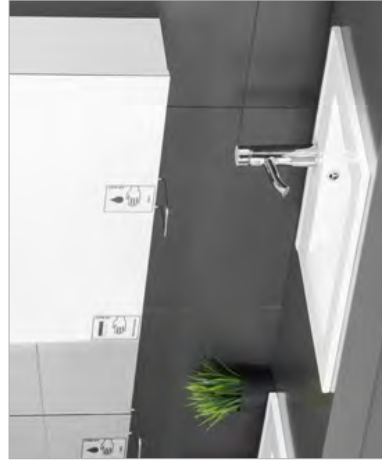
Ansicht bei geschlossener Spiegelfront: Nur der Bediemenhebel ist für den Benutzer sichtbar. Ein Spiegel-Aufkleber zeigt an, wo sich der Seifenspender befindet.
