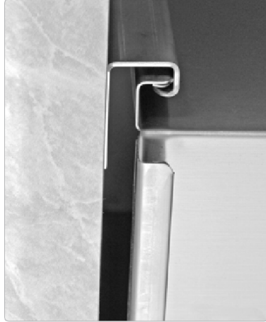
Art. 20-144: Aufhängung oben an Führungsschienen (an Waschtischunterseite).
