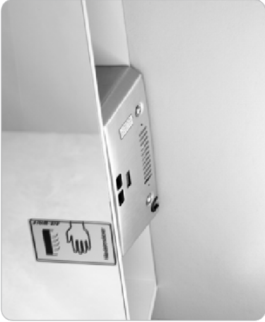
Händetrockner der Serie B hinter geschlossenen Spiegel, gekennzeichnet durch einen Aufkleber.
